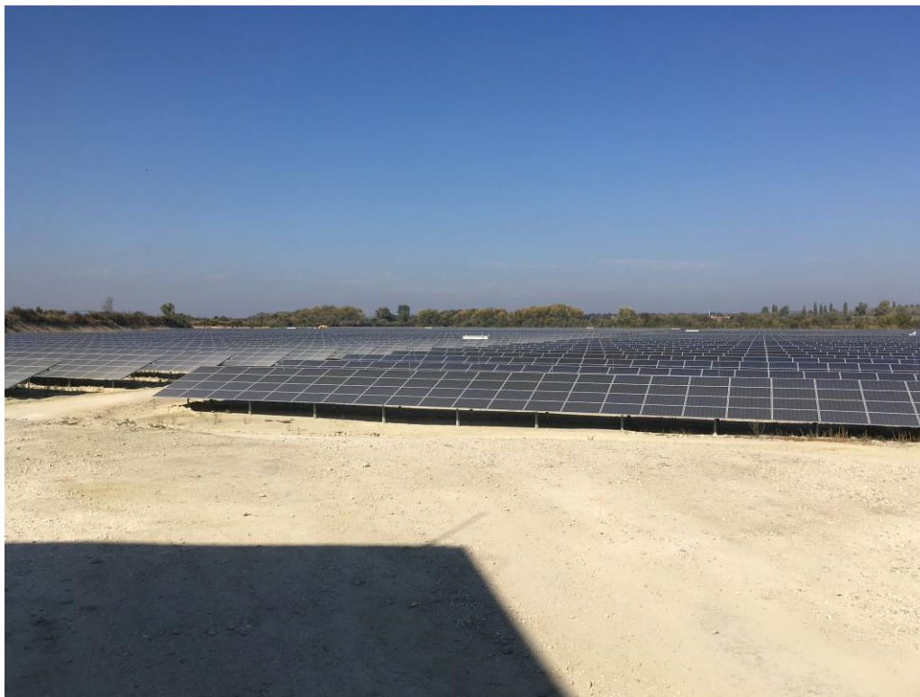
5. kép Tehagi solar park
