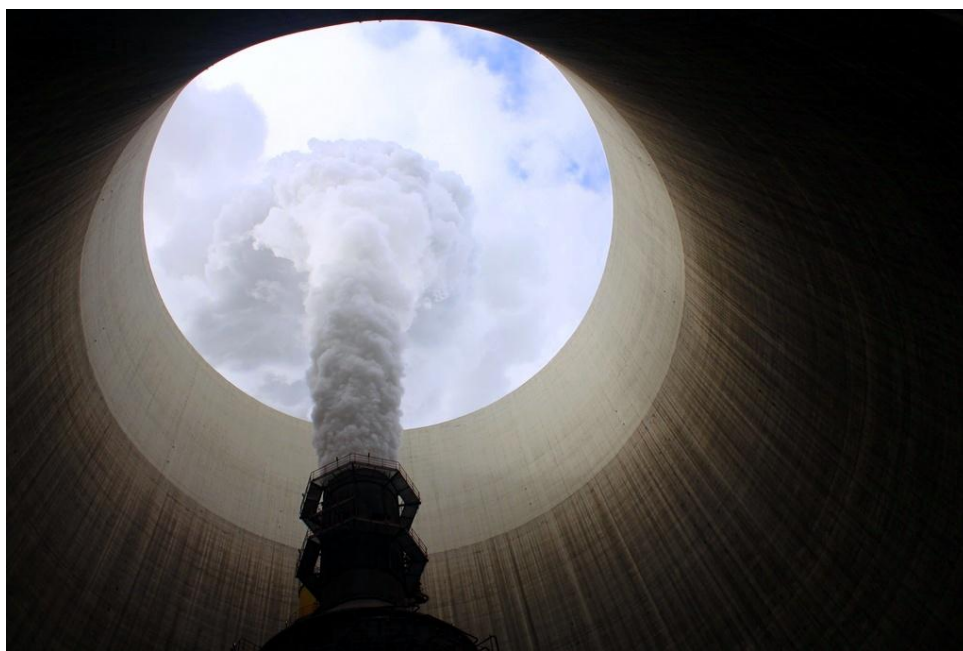
4. ábra A kéntelenítő kéménye a hűtőtorony belsejében
