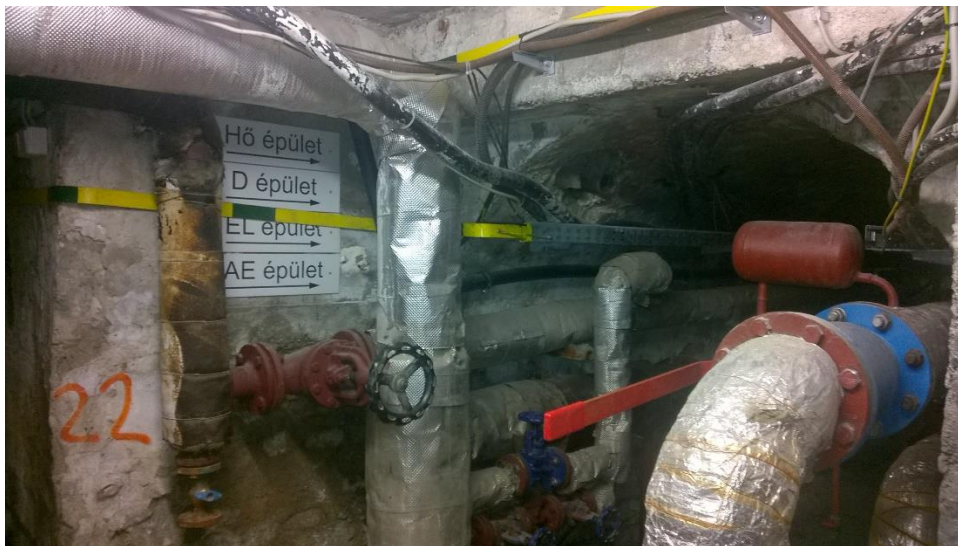
2. ábra: Folyosó a Hő épülethez
