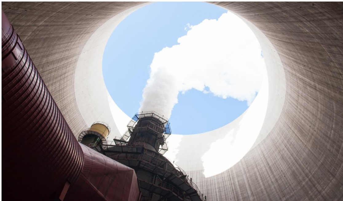
1. Kép A száraz hűtőtorny belseje, és a füstgáz kéntelenítő
