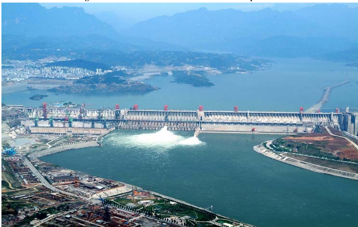
1. kép. Három Szoros Vízérőmű
