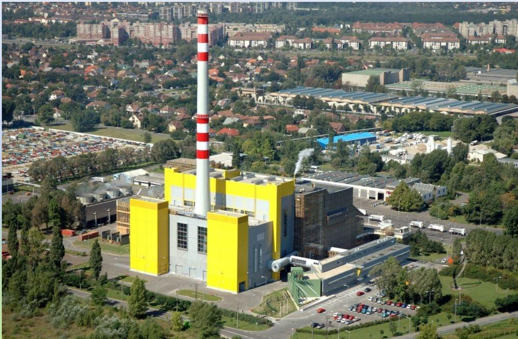
Hulladékhasznosító Mű a rekonstrukció után
