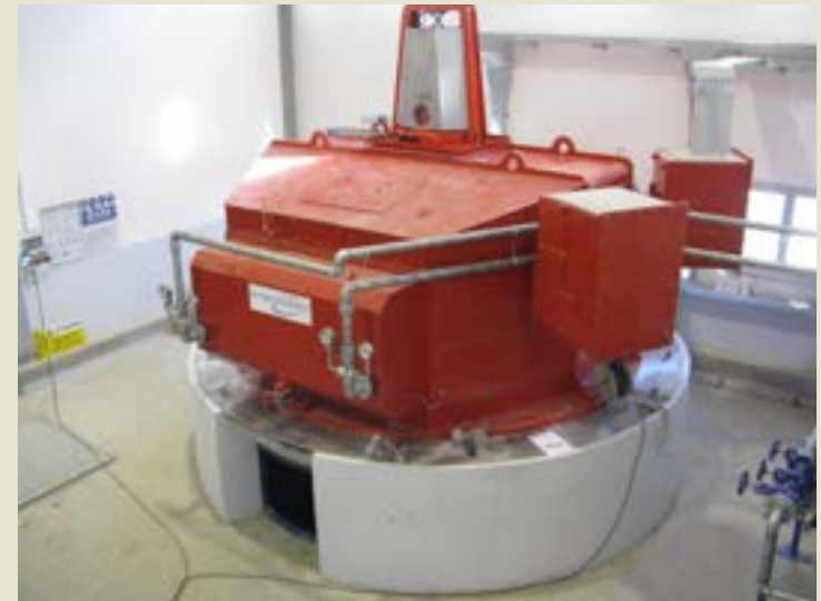
Ganz 2011 ONv2640x280/40 Crema (Olaszország), Kaplan 27,5tonna / 1,2MVA = 22,9tonna/MVA 150ford/perc, azaz 40pólus
